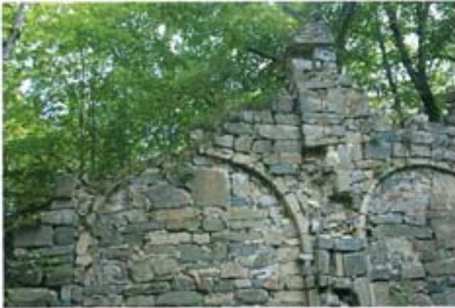
ინტერიერი. ხედი ჩრდილოეთით
