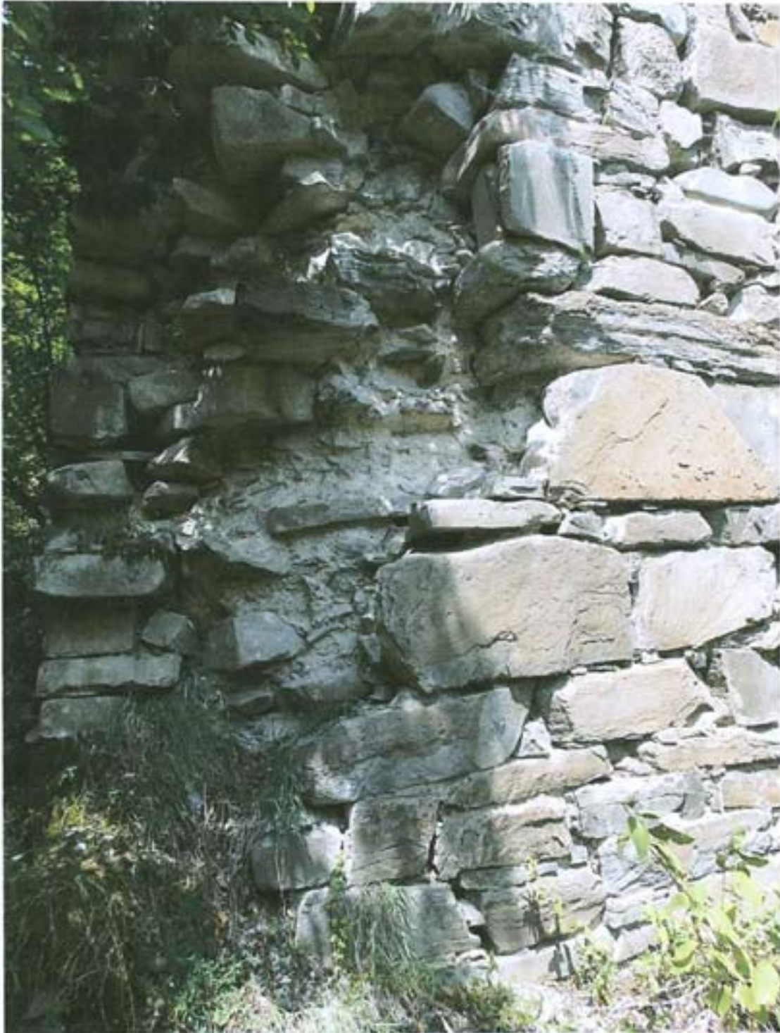
2. შენობის მზიდი კონსტრუქცია მთლიანად ქვის ბლოკების წყობაა; ქვის წყობით არის გადაყვანილი ეკლესიის თაღური გადახურვაც.
