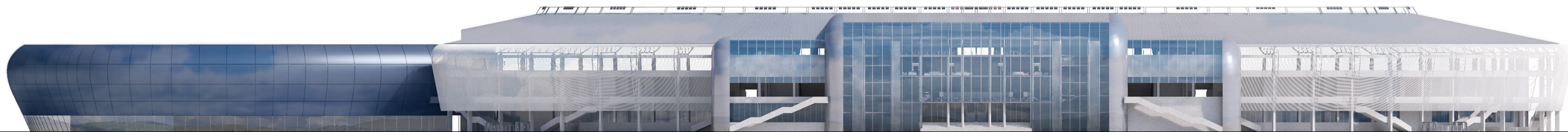
WEST FACADE / ხედი დასავლეთიდან
