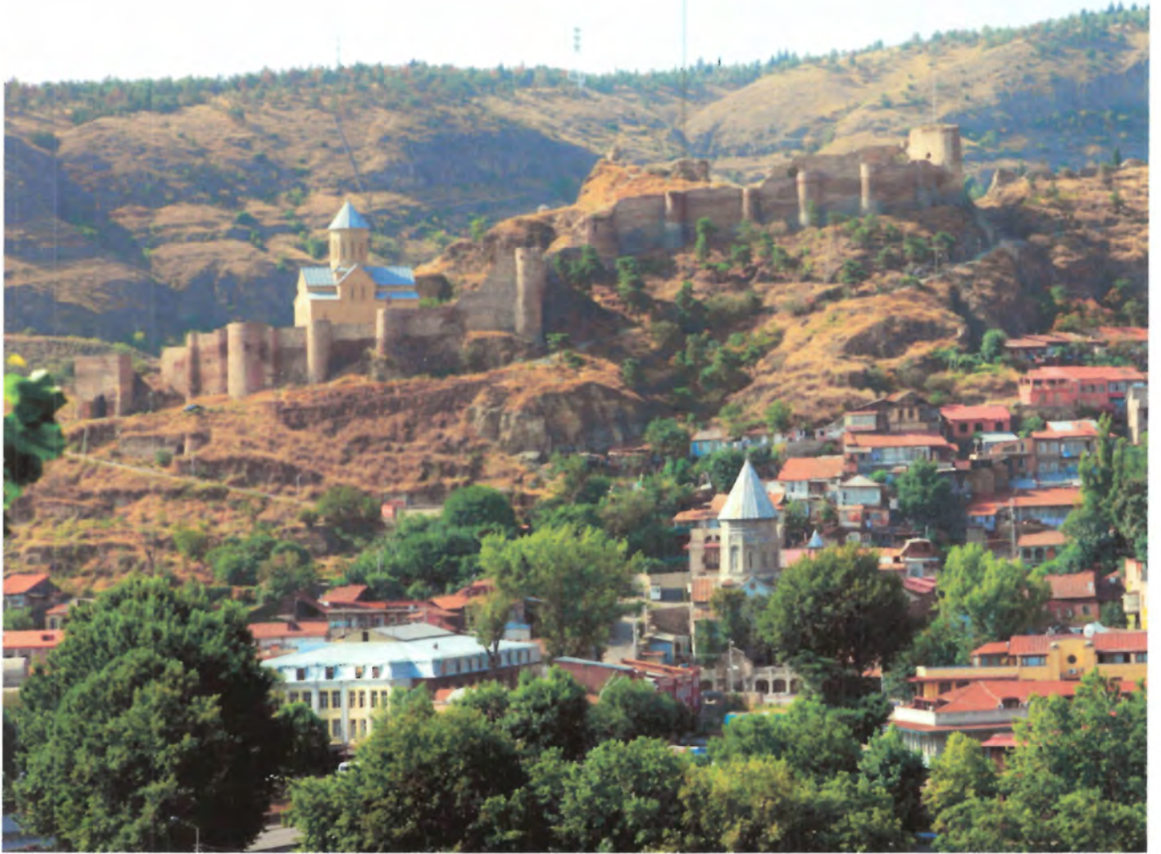
ნარიყალა, ხედი ჩრდილოეთიდან
