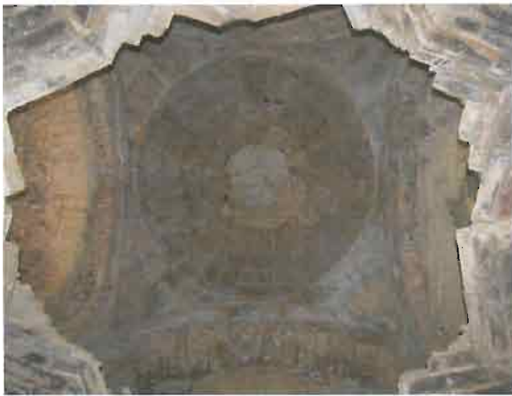
სამრელოს 1=ლი სართულის გადახურვის ჩამონგრეული ნაწილი- უკანა პლანზე მე-2 არსებული სამლოცველოს გუმბათი
