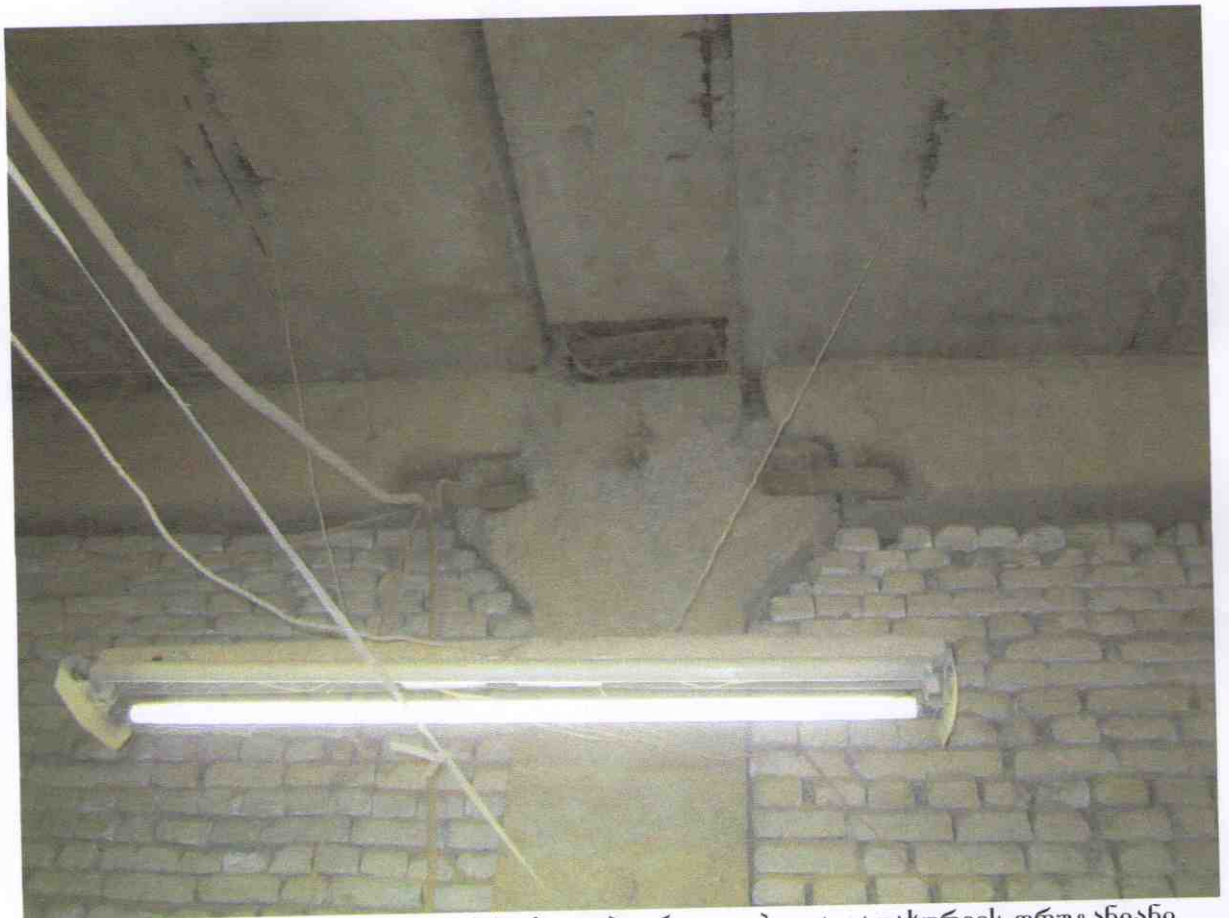
ფოტო 2. რკინაბეტონის ანაკრები სვეტები, რიგელები და გადახურვის ღრუგანიანი ფილები.
