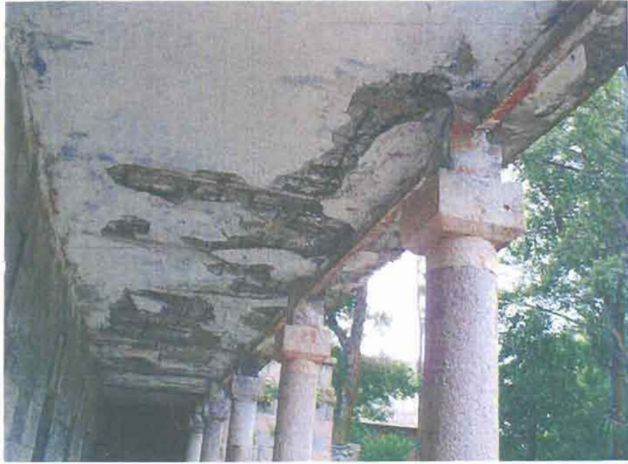
სურ. 11- დაზიანებული რ/შ აივანი. ხედი შიგნიდან.
