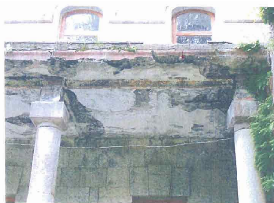
სურ. 12- დაზიანებული რ/შ აივანი. ხედი გარედან.
