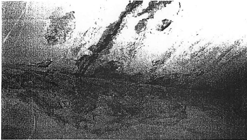
სურ.6. გადახურვის ფილა მეორე სართულზე ბეტონის გამოტუტვის ნიშნით.
