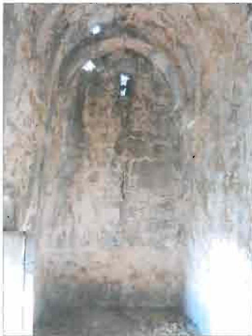
ინტერიერი. დაზიანებული კამარა დასაკლეთ კედელთან
